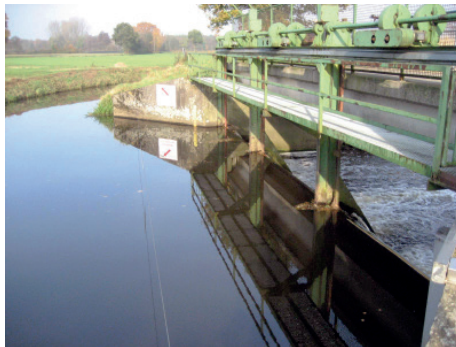
Stahlkonstruktion der Wehranlage War mit drei Wehrfeldern und flankierender Straßenbrücke
