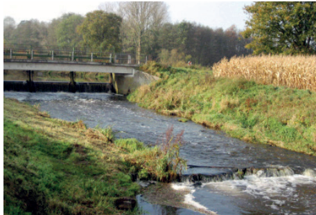
Vorhandene Sohlgleite mit Wasserbausteinen und Pfahlreihen
